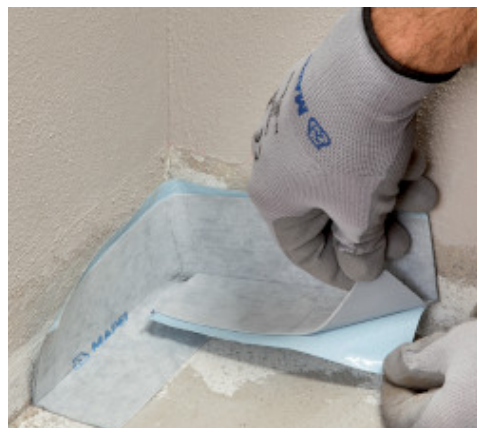
Mapeband SA bedolgozása sarokba
