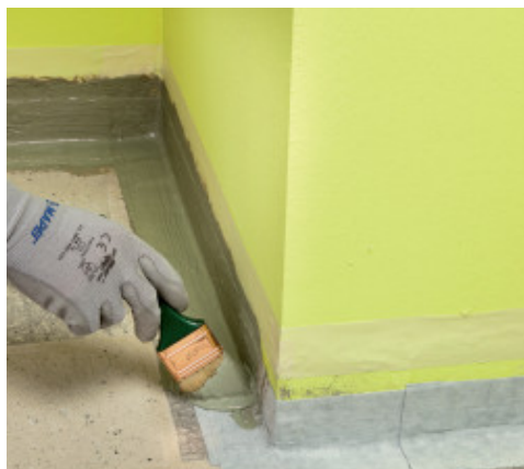
Mapeband SA bedolgozása esztrichre
