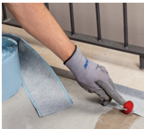
Mapeband SA bedolgozása élekhez
