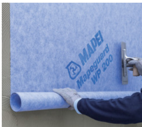
Mapeguard WP 200 fektetése
