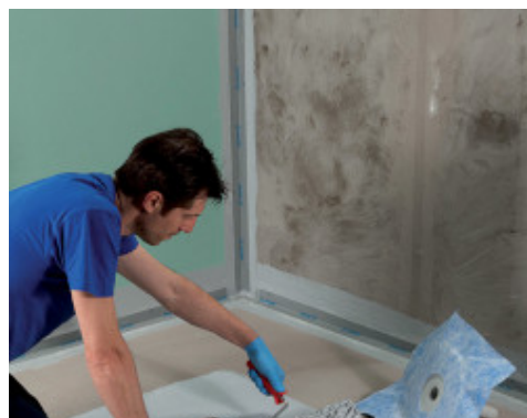
Drain Vertical csatlakoztatása Mapegum WPS-sel
