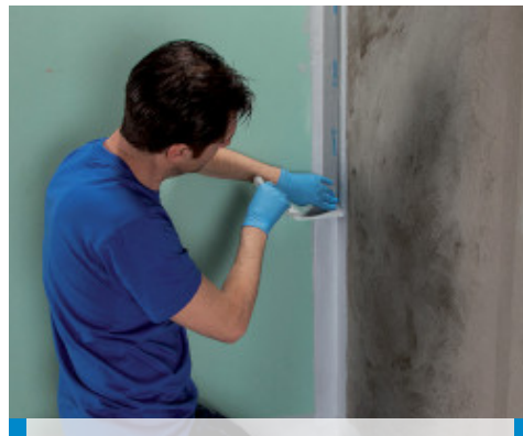
Mapeband PE 120 mandzetta elhelyezése kifolyó körül Mapegum WPS-sel
