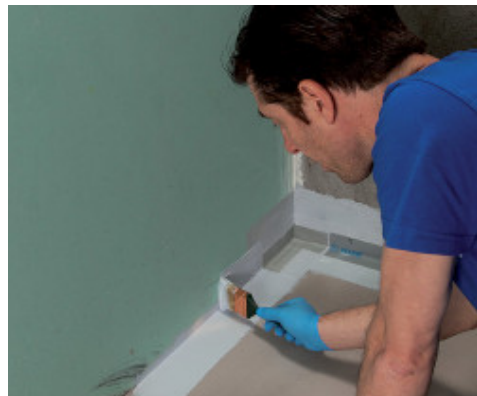
Mapeband PE 120 szalag elhelyezése Mapegum WPS-sel
