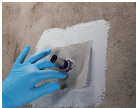
Mapeband PE 120 mandzetta elhelyezése kifolyó körül Mapegum WPS-sel
