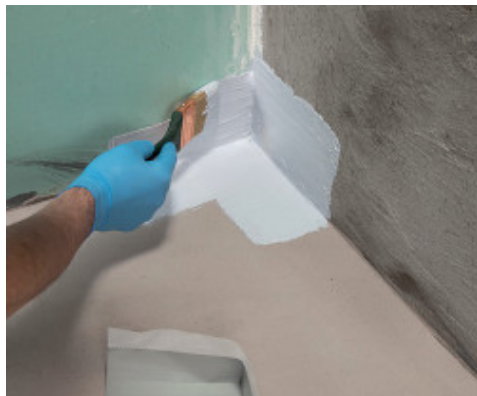
90°-os Mapeband PE 120 sarokelem elhelyezése Mapegum WPS-sel
