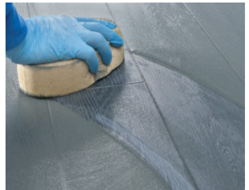
A fugahézagok tisztítása és felületképzése kemény cellulóz szivaccsal
