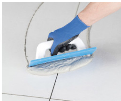
Ultracolor Plus bedolgozása gres padlóburkoló lapokra gumisimítóval
