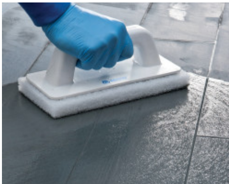
Fugahézagok tisztítása Scotch-Brite® filccel (amikor a termék csak félig kötött meg)
